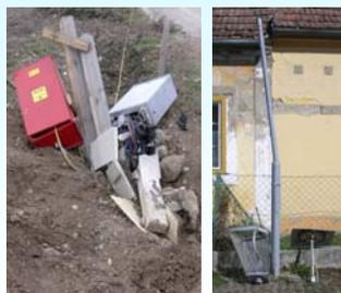
Beschädigter Kabelverteilungskasten oder Lichtmast: 230 V gegen Erde
